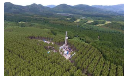
山下池南部地域調査井掘削状況
