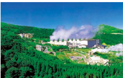
八丁原発電所
