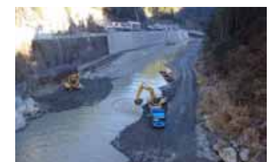
土砂移動工事状況（諸塚中心部土砂浚渫）
