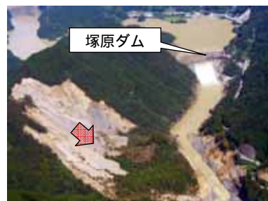
塚原ダム下流の斜面崩壊状況
