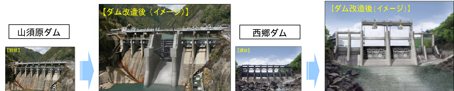
山須原ダム 既設ラジアルゲート8門のうち、中央2門を撤去後、越流天端を約9m切り下げて、ラジアルゲート1門を設置
