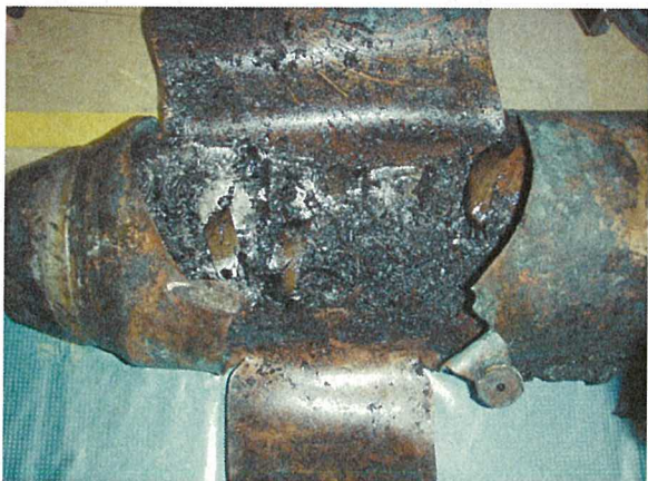
事故箇所の破断した保護銅管
