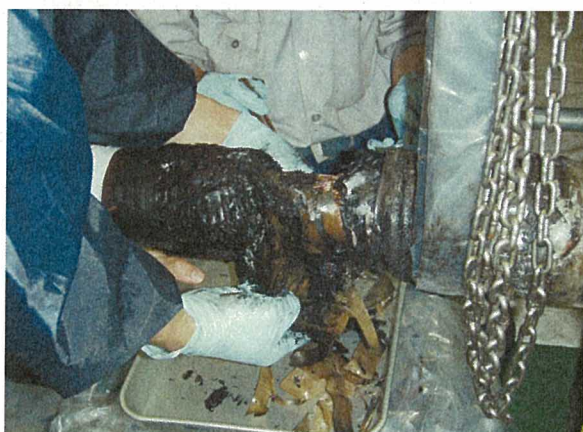
事故箇所の焼損した絶縁紙を除去
