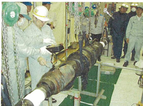
解体前の諸測定
