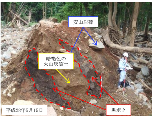
写真－2 集落最上流部付近の崩壊土砂の写真①
