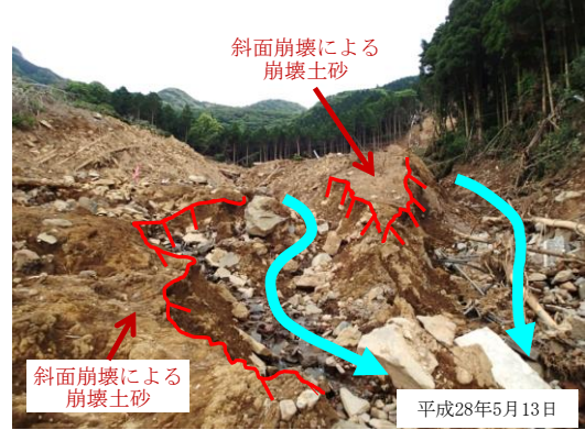
写真－3 斜面上に堆積した崩壊土砂の上に確認された侵食地形の写真②
