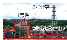
松浦発電所2号機建設状況 (2017年7月現在)
