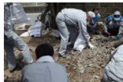
割れた瓦の撤去作業
