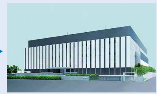
データセンター
