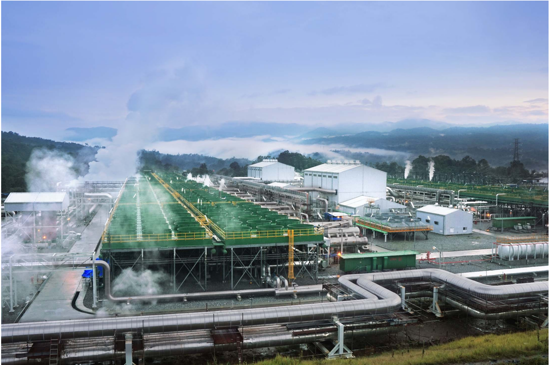
インドネシア・サルーラ地熱 I P Pプロジェクト 2・3号機
