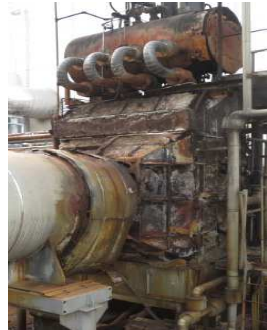
高経年化状況（排ガス熱回収装置）
