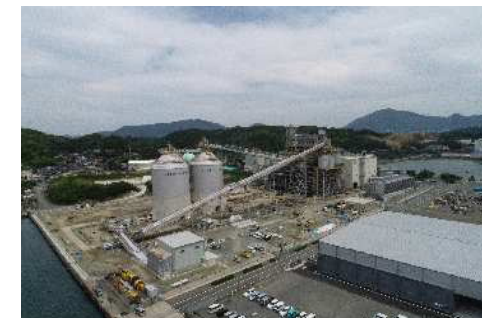
下関バイオマス発電所（山口県下関市）
