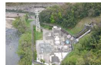
水力発電事業：新竹田発電所
