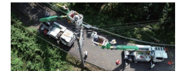
復旧作業の様子
