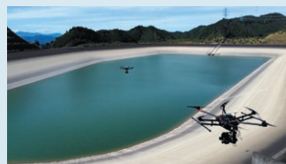
ドローンによるダム遮水壁撮影イメージ
