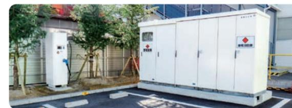
非常時は、EV/PHVの発電・蓄電能力と定置蓄電池を用いて長時間安定した電力の供給が可能です。また、平常時にはEV/PHVの充電ステーションとして利用するだけでなく、電力デマンドピークの抑制を行い、電力料金を低減することが可能です。充電ステーションは、10kW/台を5台まで設置することができます。
