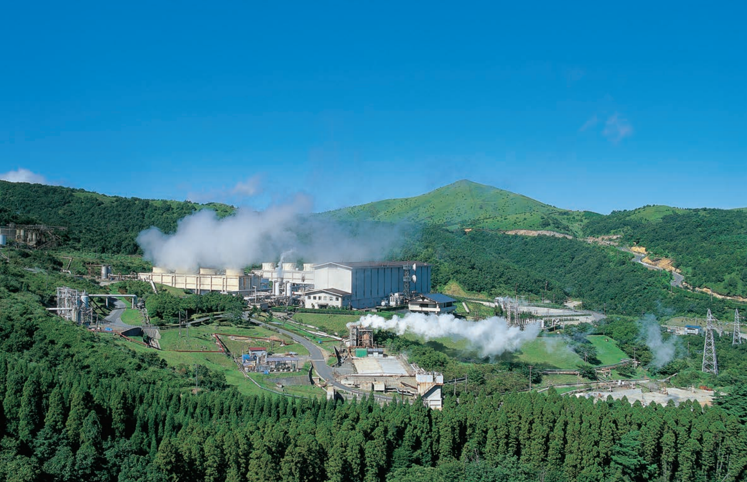
八丁原発電所 (大分県九重町)
