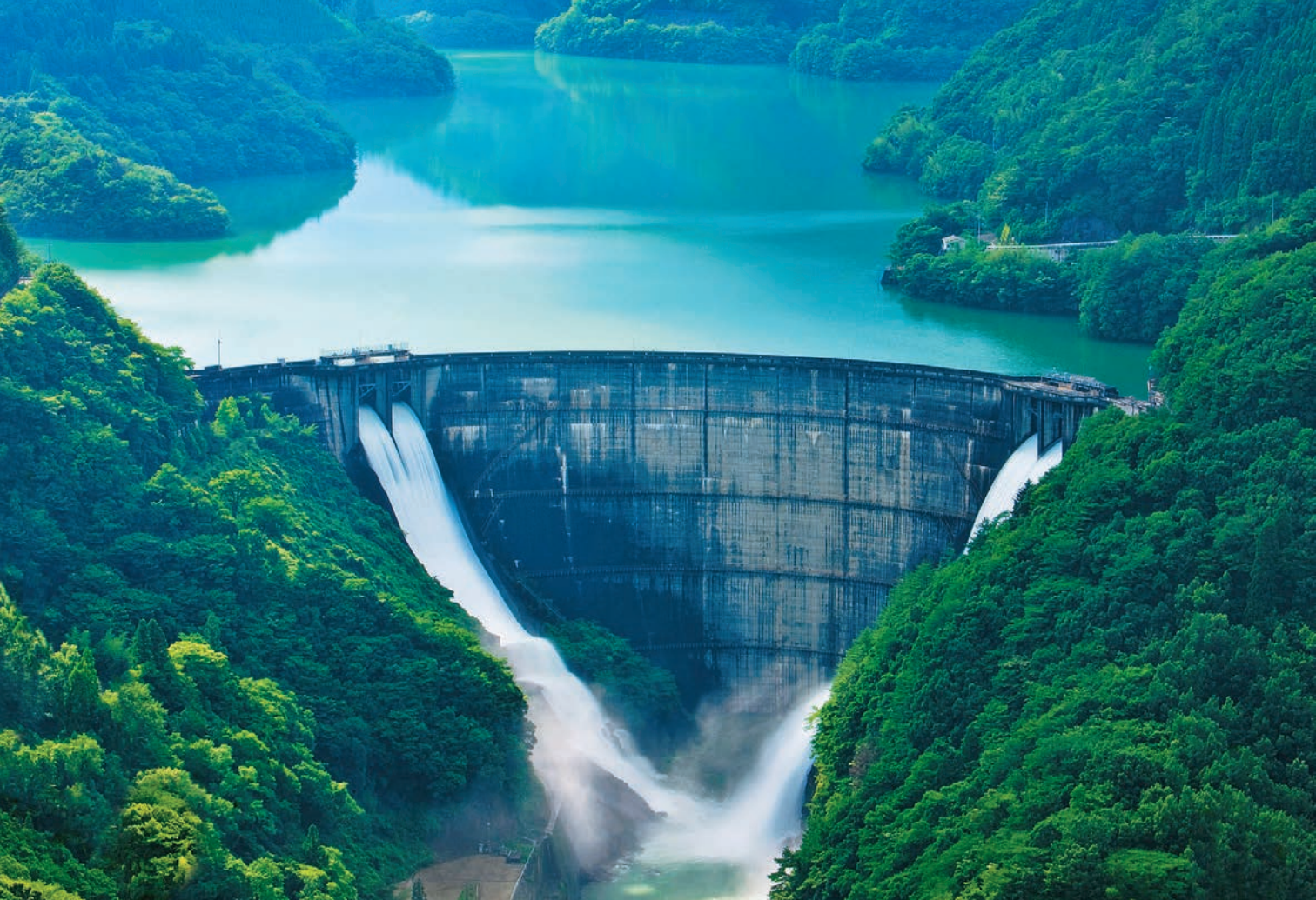
上椎葉発電所（宮崎県椎葉村）
