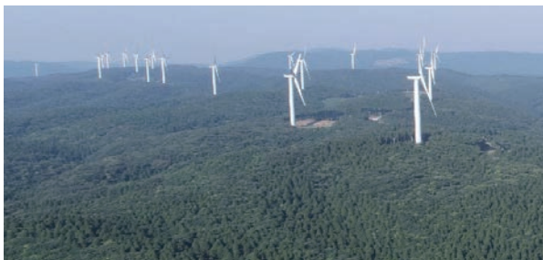
串間風力発電所
