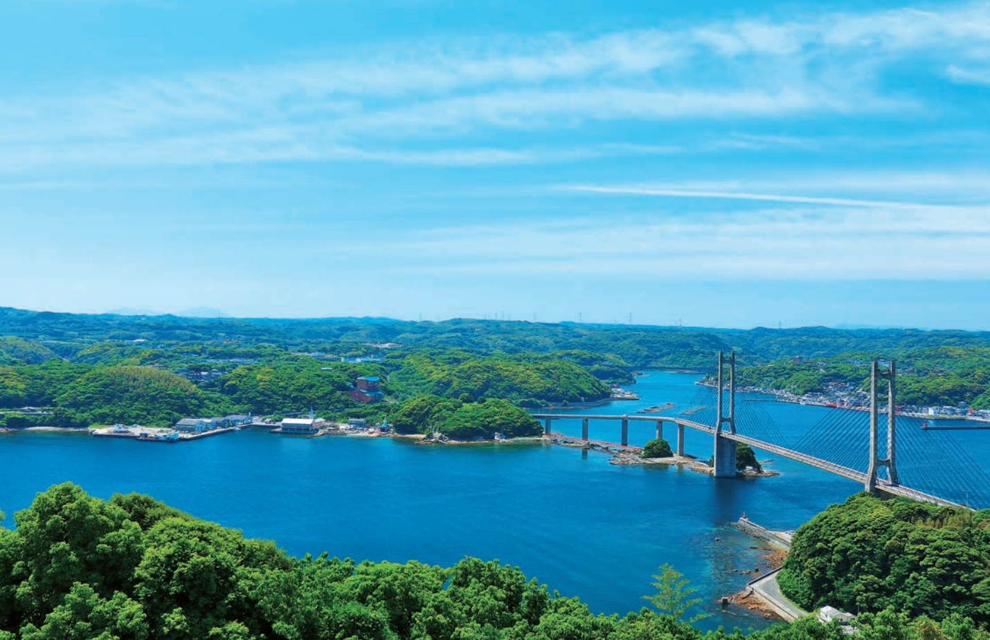
呼子大橋 (佐賀県唐津市)
