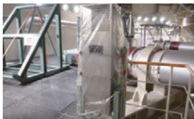
静的触媒式水素再結合装置
