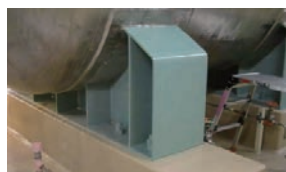
地震対策(支持構造物補強)
