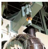
地震対策(支持構造物補強)
