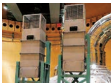
静的触媒式水素再結合装置
