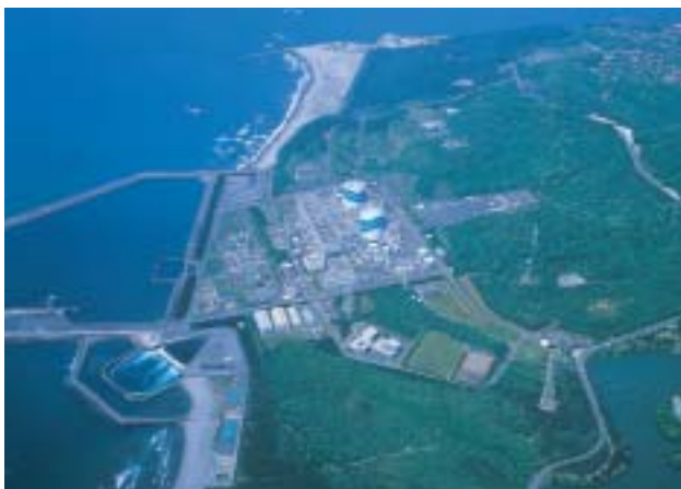
川内原子力発電所
