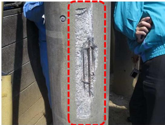
コンクリート損傷部への補修材
