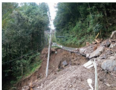
支持物流出・電線断混線
