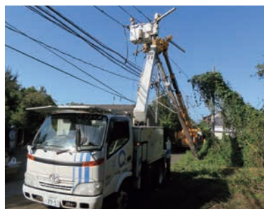
復旧作業の様子
