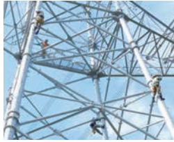
送電鉄塔の設備点検
