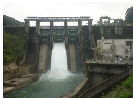
水力発電所の維持管理 (大淀川第一発電所)
