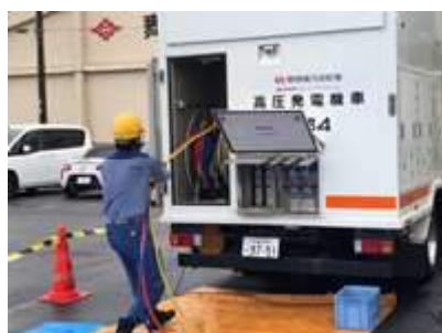
第八管区との電源供給訓練
