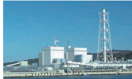
2023年4月から九州電力初のアンモニア混焼試験を実施している茨北発電所(熊本県)
