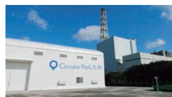
サーキュラーパーク九州(株)(鹿児島県薩摩川内市)
