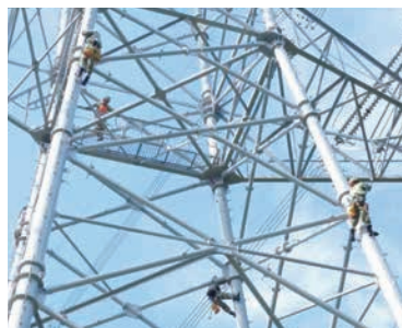
送電鉄塔の設備点検
