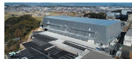
グローバルロジ基山(佐賀県三養基郡)
