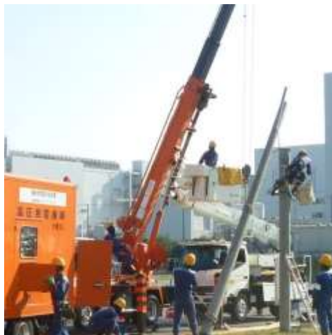
電力設備復旧
