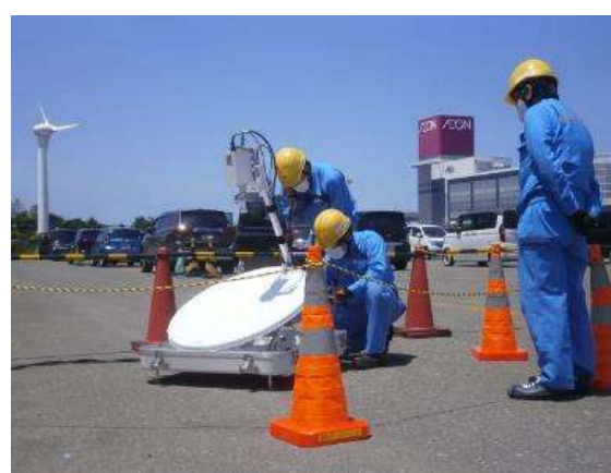
衛星回線を活用した通信回線設置
