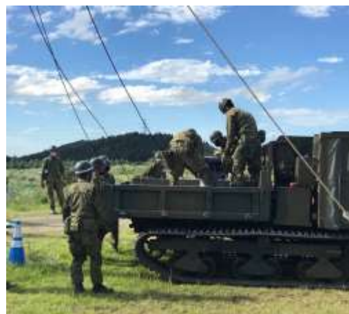
不整地運搬車による変圧器運搬
