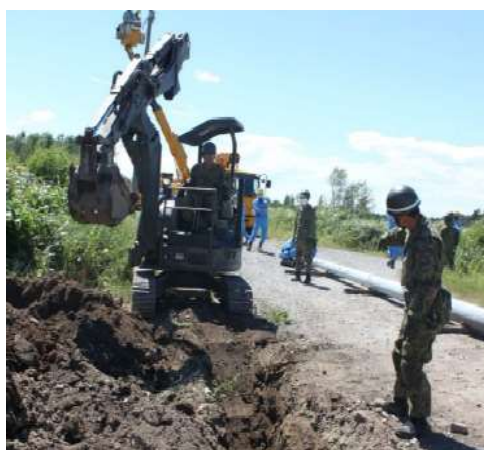
電柱建て込み場所の掘削作業
