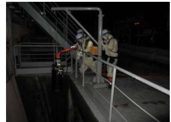
取水用水中ポンプの現場設置訓練
