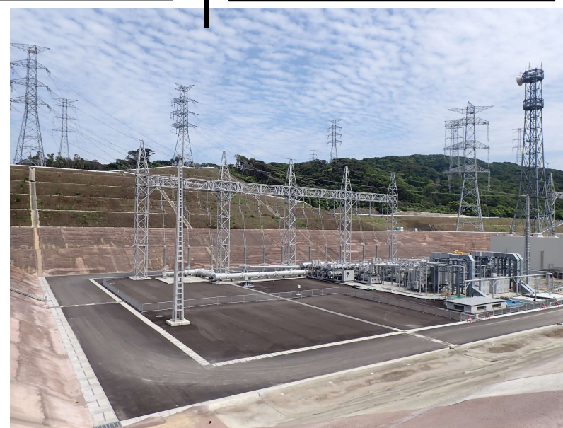
特高開閉所 工事状況（220kV工事完了）
