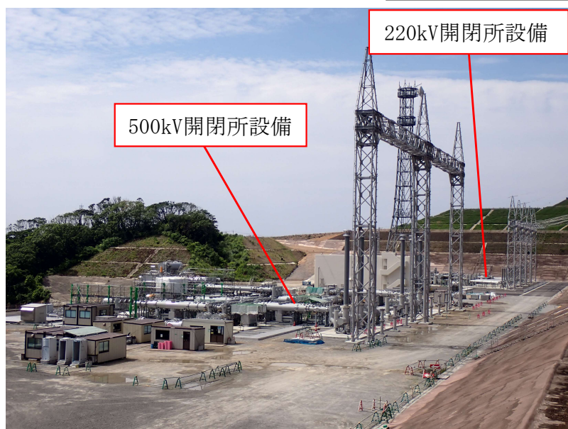
特高開閉所 工事状況（全景）
