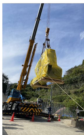
水力発電所のリプレース [玉島発電所] （左：水車・発電機の搬入、右：水車・発電機取替後）
