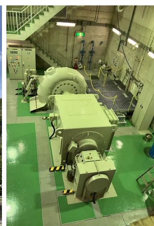
水力発電所のリプレース [玉島発電所] （左：水車・発電機の搬入、右：水車・発電機取替後）
