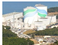
川内原子力発電所 (鹿児島県)
