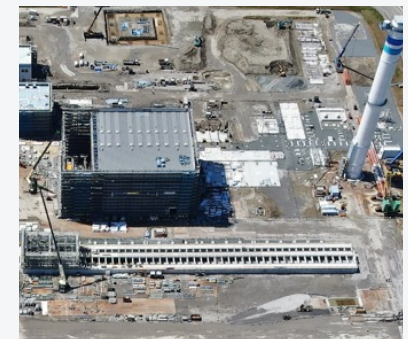
ひびき発電所の建設状況(2024年3月)
