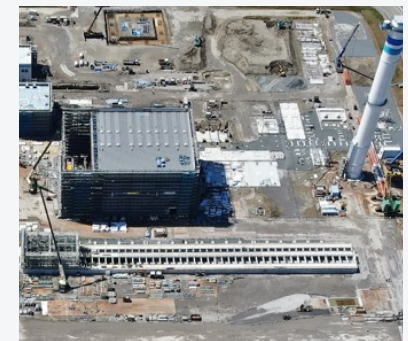
ひびき発電所の建設状況(2024年3月)
