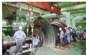
定期検査の様子
