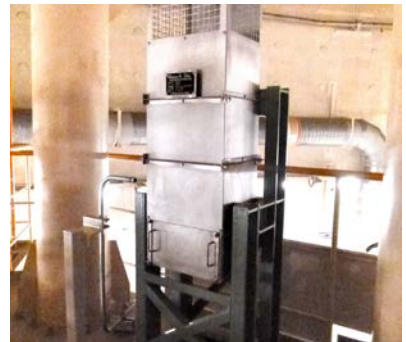
■ 静的触媒式水素再結合装置
