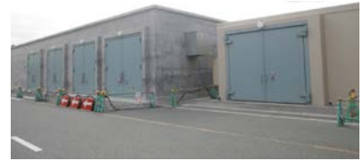
■ 資機材等を収納する保管庫(玄海)
