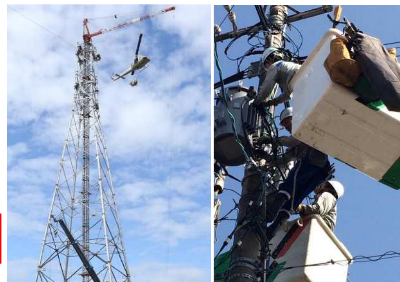
ヘリによる仮鉄塔架線作業
