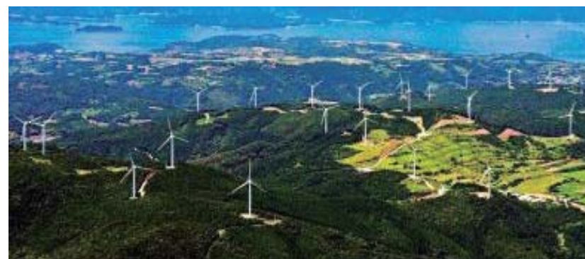
長島風力発電所（グループ会社の長島ウインドヒル株式会社）
