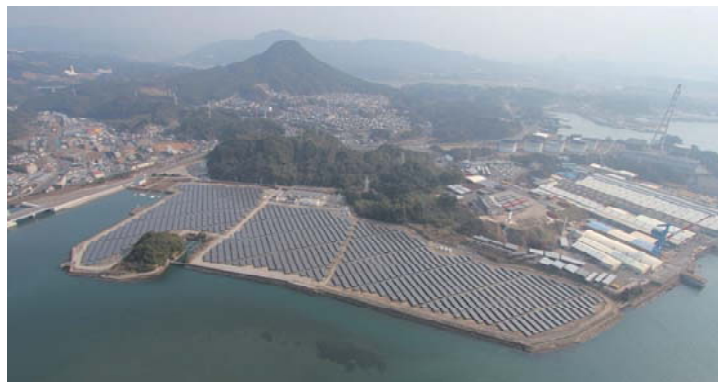
佐世保メガソーラー発電所（グループ会社の九電みらいエナジー株式会社）
