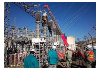
安全パトロールの様子
