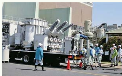
外部電源復旧訓練
