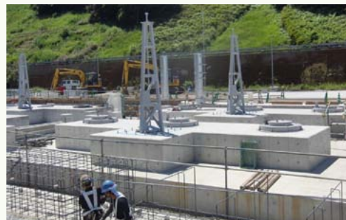
非常用ディーゼル発電機用燃料油貯蔵タンク追加設置工事
