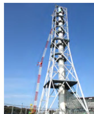
新大分発電所3号機(第4軸)の建設現場
