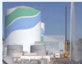
放水砲による放水試験
