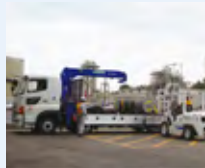
電源ケーブルの運搬
