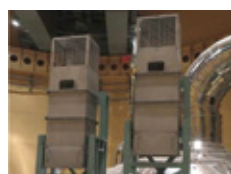
静的触媒式水素再結合装置
