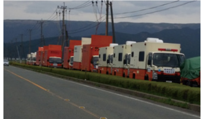
高圧発電機車による送電(関西電力(株))
