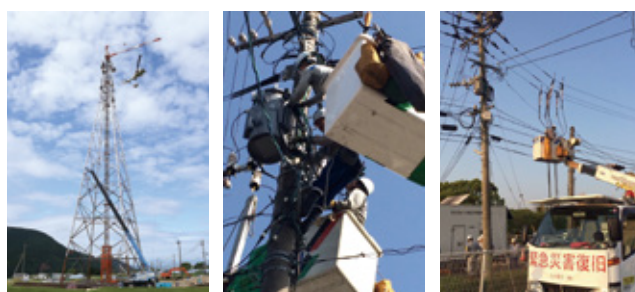
▲仮鉄塔架線作業
