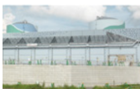
海水ポンプエリアの防護壁
