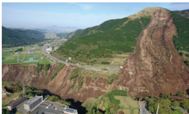
大規模な土砂崩れ(熊本県南阿蘇村)
