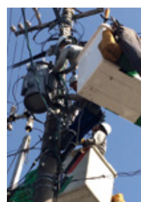
▲配電線復旧作業
