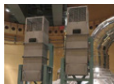
静的触媒式水素再結合装置
