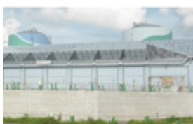
海水ポンプエリアの防護壁
