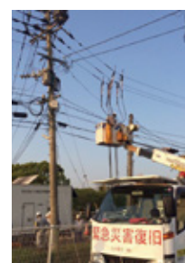
▲発電機車による送電
