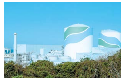
川内原子力発電所
