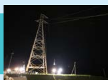
熊本地震における 復旧作業の様子
