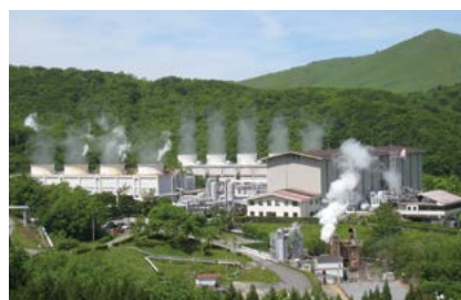
八丁原発電所
