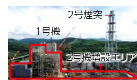
松浦発電所2号機建設状況 (2017年7月現在)
