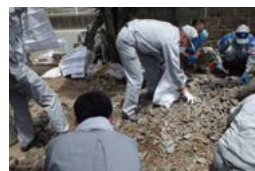
割れた瓦の撤去作業
