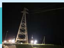
熊本地震における 復旧作業の様子
