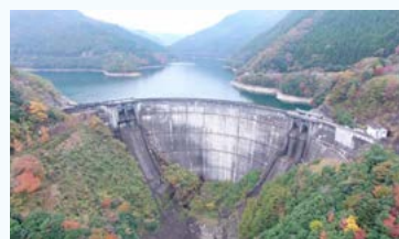
日本初のアーチ式ダム「上椎葉発電所」
