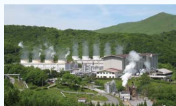
日本最大の地熱発電所「八丁原地熱発電所」
