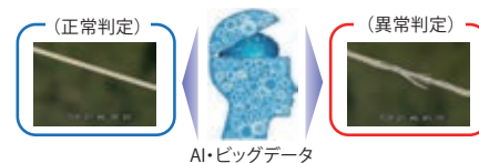
▲AI及びビッグデータを活用した電線の異常判定
