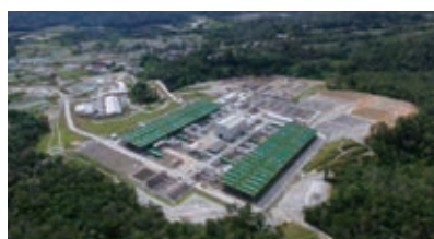
▲世界最大規模の地熱発電所 (インドネシア サルーラ)
