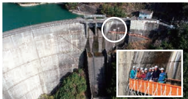
▼ ツアーの様子 (宮崎県上椎葉ダム)
