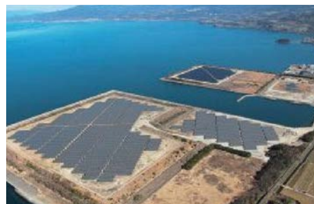
大村メガソーラー発電所
