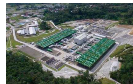
世界最大の地熱発電所 (インドネシア サルラ)
