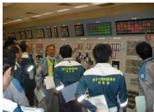
現場調査【中央制御室】（玄海）
