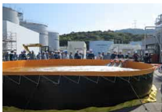
現場調査【中間受槽】（川内）
