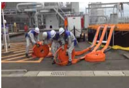
原子炉を継続して冷却するための仮設ポンプによる冷却水供給訓練
