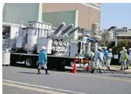
通常を送電線ルートが機能しなくなった場合を想定し、移動用変圧器を発電所内に設置して別ルートから電力を供給する訓練
